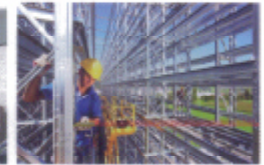
危険な現場での水平距離測定
